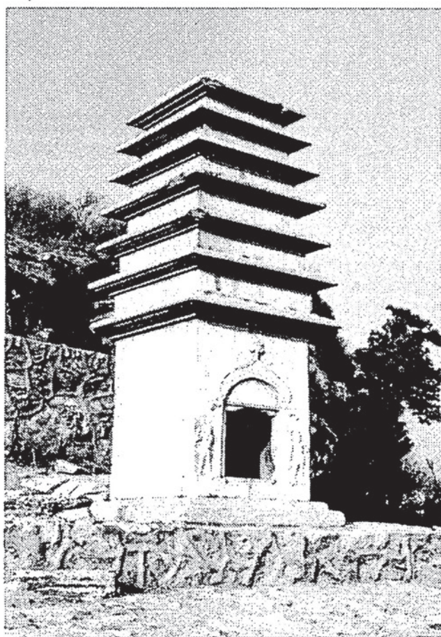
＜写真7 金仙公主塔 房山石経山頂＞
