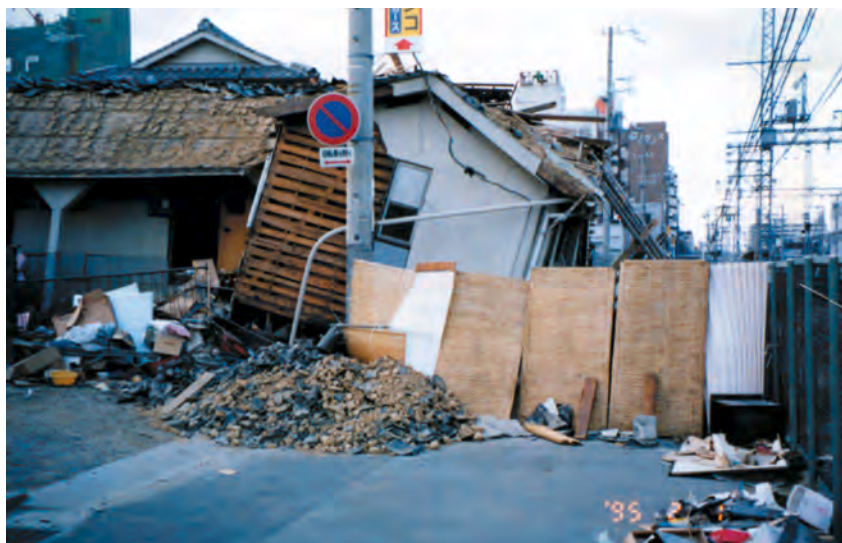
阪神淡路大震災で倒壊寸前の住宅（阪急沿線沿いで）
