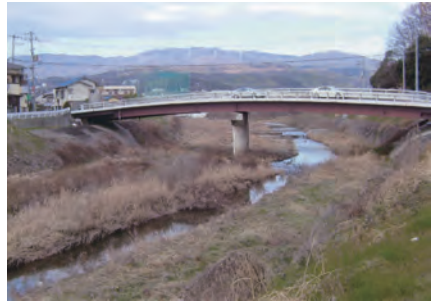
白井河原 上野町付近
